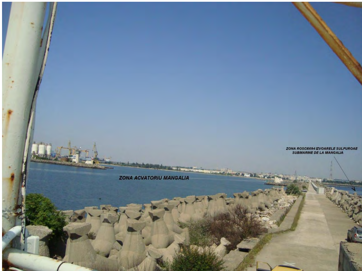
Figura 2.1.6-3 Delimitarea zonei acvatoriului de ROSCI0094 Izvoarele sulfuroase submarine de la Mangalia (vedere de pe dig dinspre Marea Neagră spre uscat – plajă).
